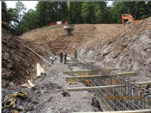
Photo 9 Concrete placement - pour 2
