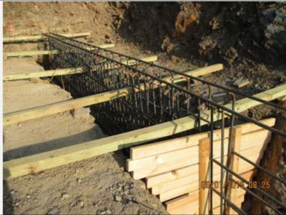
Photo 7 Steel braced and bulkhead ready for pour 1
